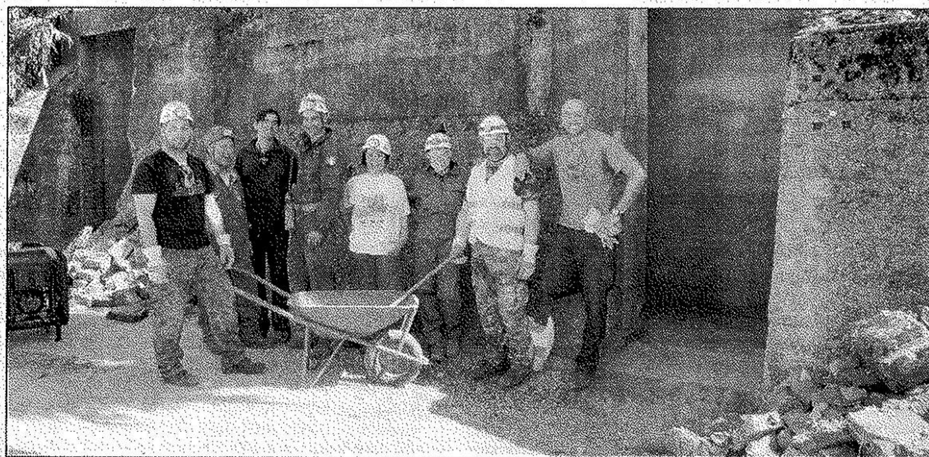
La demolizione ieri del muro all'ingresso del bunker e sopra l'interno del rifugio antibombe sotto i Giardini (Foto Blitz)
