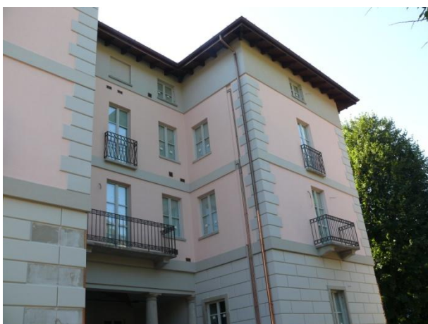
IMMOBILIARE LA BEFFA – Bisuschio (VA) Completa ristrutturazione e restauro conservativo di immobile storico ultracentenario vincolato
