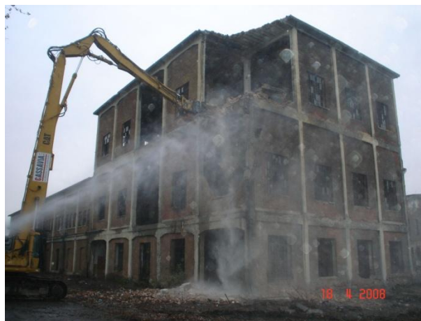
CASAFORTE SELF-STORAGE SPA - Torino Demolizione e nuova edificazione terziaria
