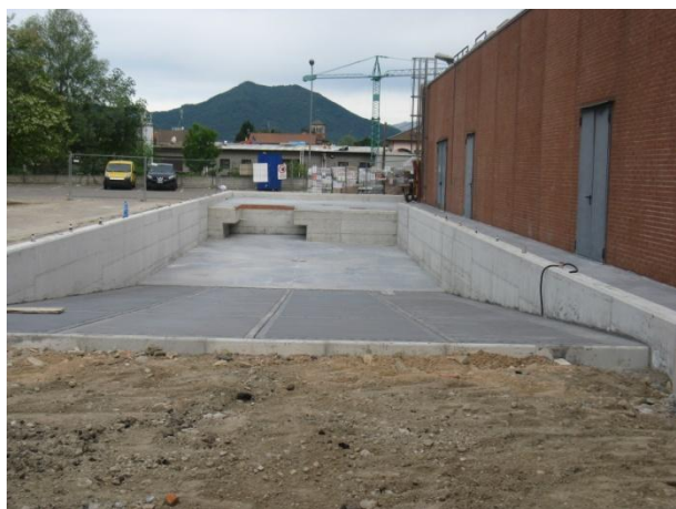
TIGROS SPA – Cunardo (VA) Vista rampa di carico e viabilità
