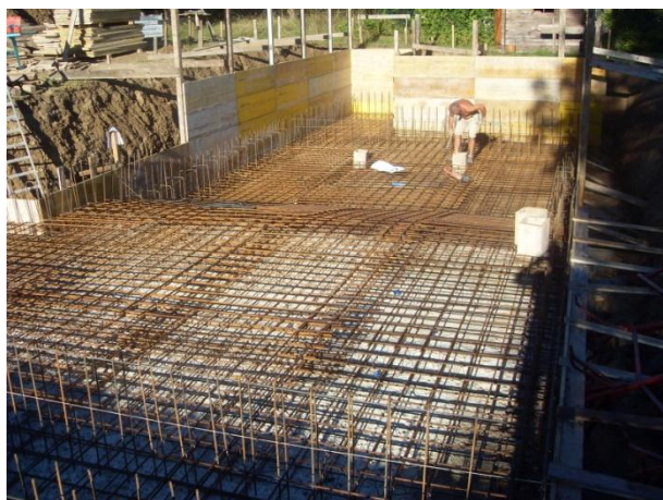
AZZATE Realizzazione di nuova piscina in muratura
