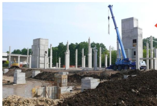
BRUNO ANGELA SPA – Arsago Seprio (VA) Nuova costruzione terziaria
